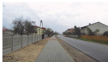
Raczkowice Kolonia -krawężniki 450m + 680 m 2 chodnika (wartość 120.000 zł, dot. 60.000zł, udz. wł. 60.000 zł),
